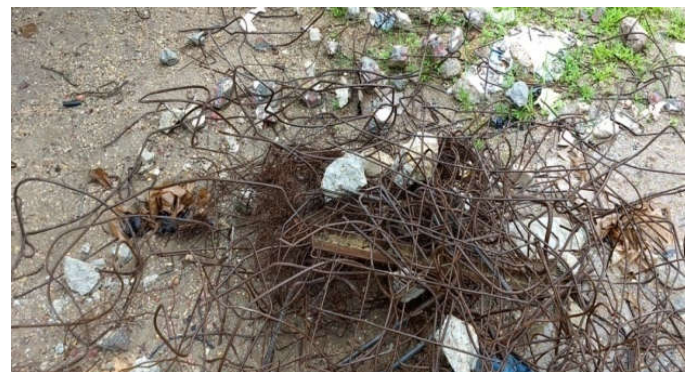
Figura 3. Aço separado em separação do concreto
