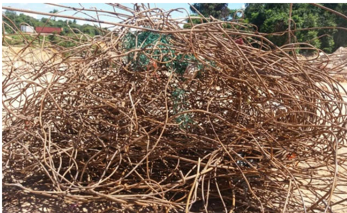
Figura 5. Barras de aço separadas para retificação
