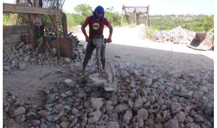
Figura 2. Redução nos blocos de concreto
